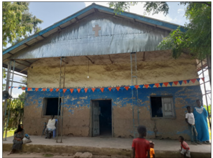
Proceso de construcción de la Iglesia de Yirba Gangeso
