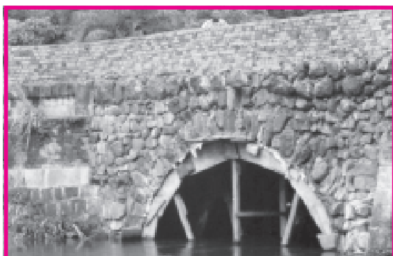
Puente de un arco, recién terminado
