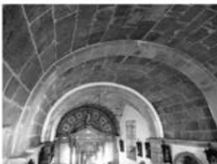
Rehabilitación Iglesia Santa María de Alón.
