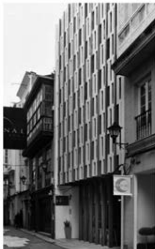
Rehabilitación edificio viviendas.
