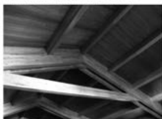
Rehabilitación Iglesia Sta. María de Guisamo.
