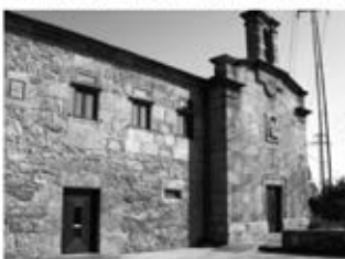
Reforma interior del Iglesario de A Grela.
