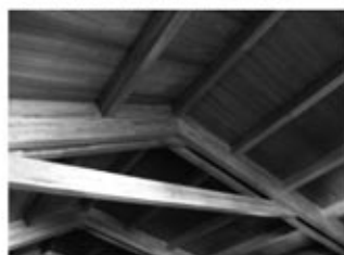
Rehabilitación Iglesia Sta. María de Guisamo.
