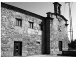
Reforma interior del Iglesario de A Grela.
