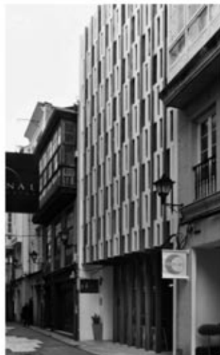
Rehabilitación edificio viviendas.
