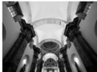
Rehabilitación Iglesia Santa Eulalia de Lians.
