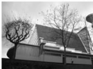
Acondicionamiento Iglesia de San José.
