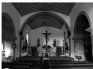
Bóveda Iglesia de Taragoña.
