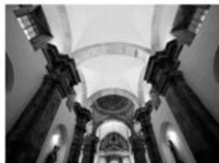
Rehabilitación Iglesia Santa Eulalia de Lians.
