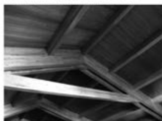
Rehabilitación Iglesia Sta. María de Guisamo.
