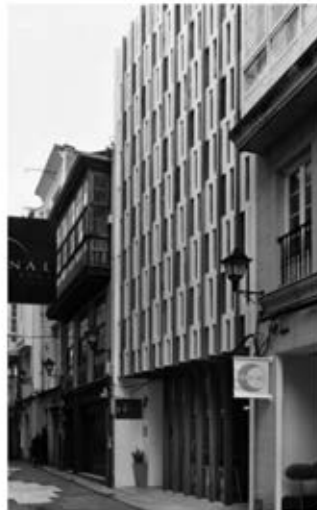
Rehabilitación edificio viviendas.
