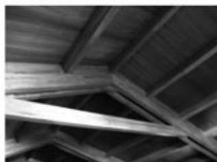
Rehabilitación Iglesia Sta. María de Guisamo.
