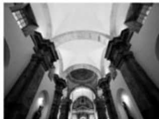
Rehabilitación Iglesia Santa Eulalia de Lians.
