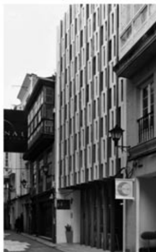
Rehabilitación edificio viviendas.
