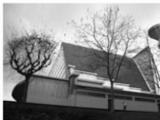
Acondicionamiento Iglesia de San José.
