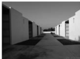
Cementerio de Carreira.
