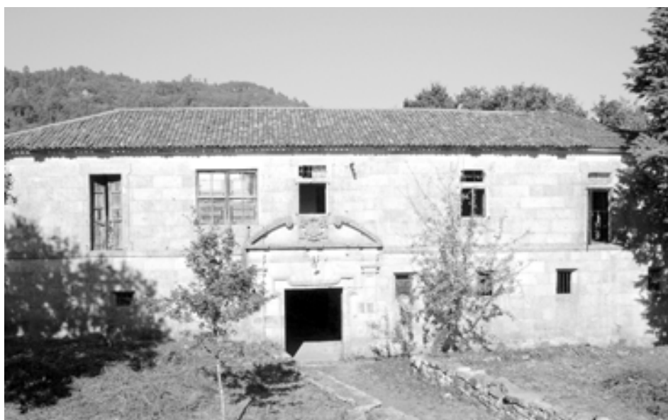
Casa prioral de Beiro. No seu interior, atopamos unha das adegas máis espectaculares de Galicia, cunha estrutura abovedada impresionante.
