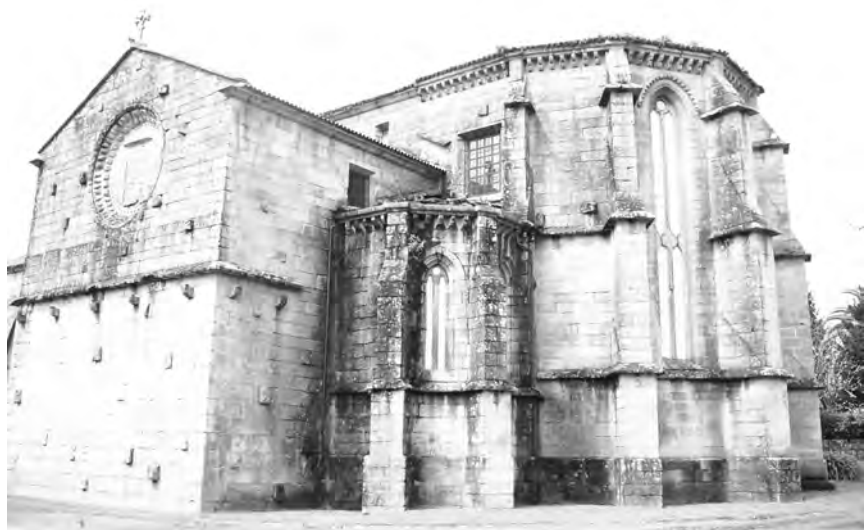
Abside e brazo sur do cruceiro do Convento de S. Domingos de Tui mostrando o gótico das ordens mendicantes
