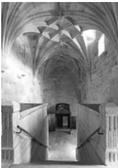
Figura 7. Vista de la Escalera entre Claus-tros. Al fondo se sitúa la puerta de acceso al brazo sur del crucero de la iglesia
