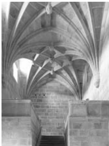
Figura 6. Vista de la Escalera entre Claus-tros desde el nivel inferior
