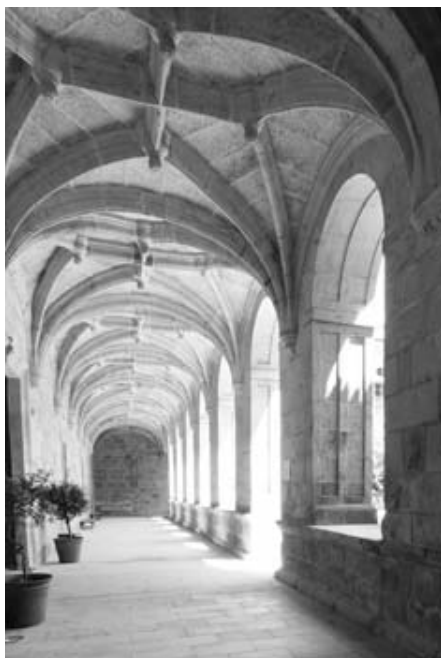
Figura 4. Galería Oeste del Claustro de la Portería
