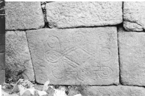
Fig. 5. Interior. Sillar con entrelazos
